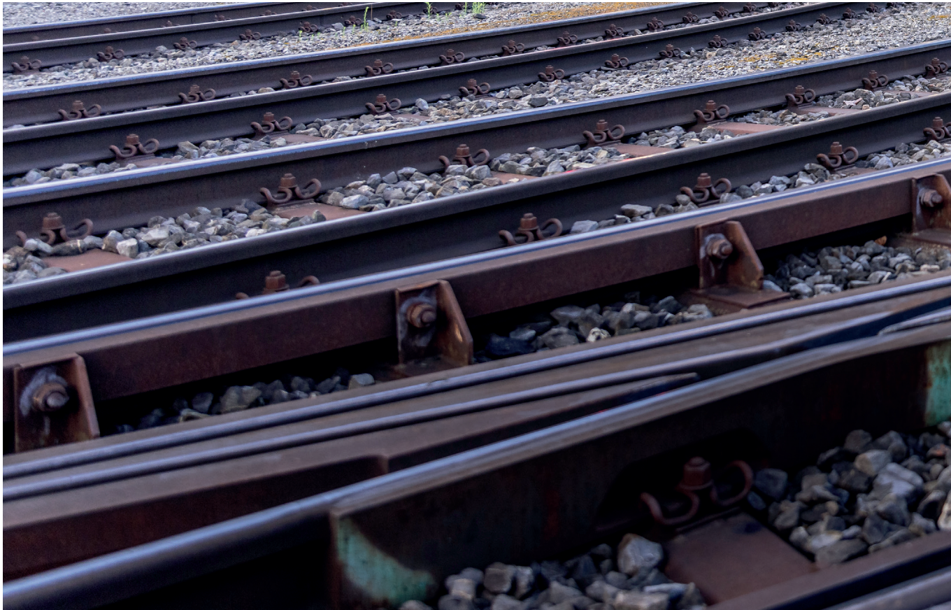
In der Anlagengattung Fahrbahn sind alle Gleise, Weichen, Unterbauten, Bahnübergänge und Schmieranlagen zusammengefasst.
